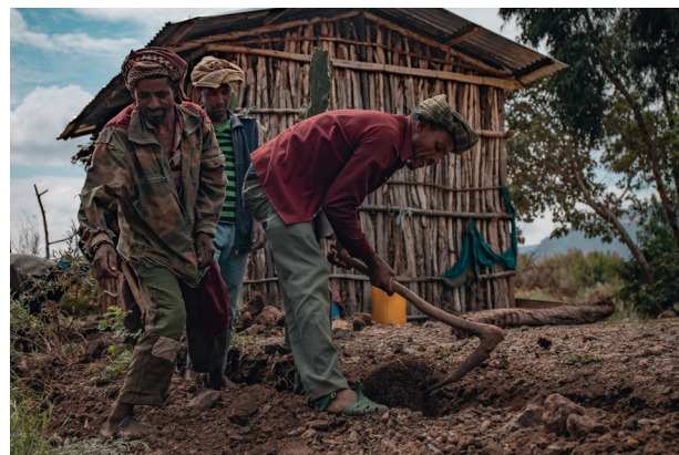
Lokal forankring er viktig. Kirkens Nødhjelps vannprosjekter blir til gjennom lokalt dugnadsarbeid, og videre drift av lokale vannkomiteer.
